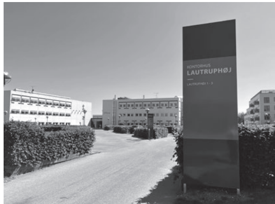
写真 3：複合オフィスビルの中にあるスペシャリスタナ
